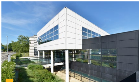
14 rue de la Cornouailles à Nantes
